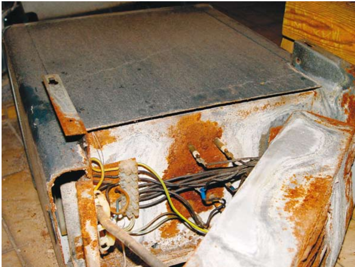
Kiuas on ruostunut vaihtokuntoon.
