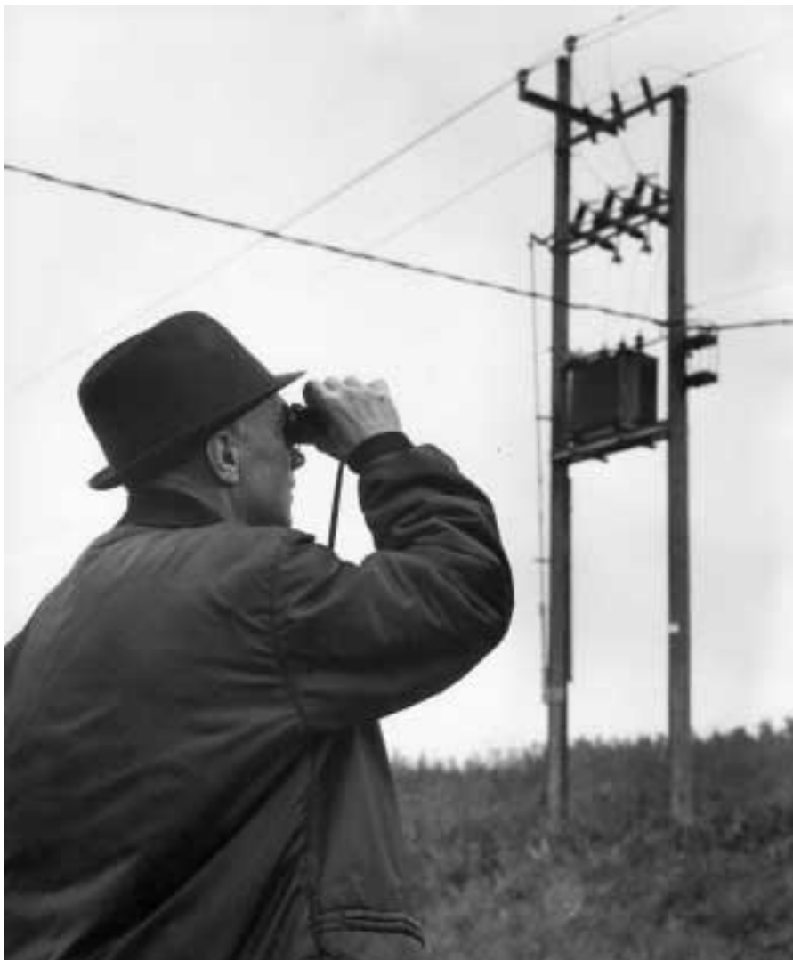
Sähkölaitososaston tarkastaja Olli Keckman tarkastaa pylväsmuuntajan rakennetta.
